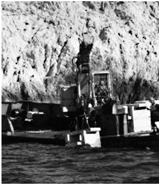
Colocación de arrecifes artificiales en los Acantilados de Maro
